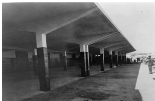
Figura 9 Imagen de la marquesina y muelle
